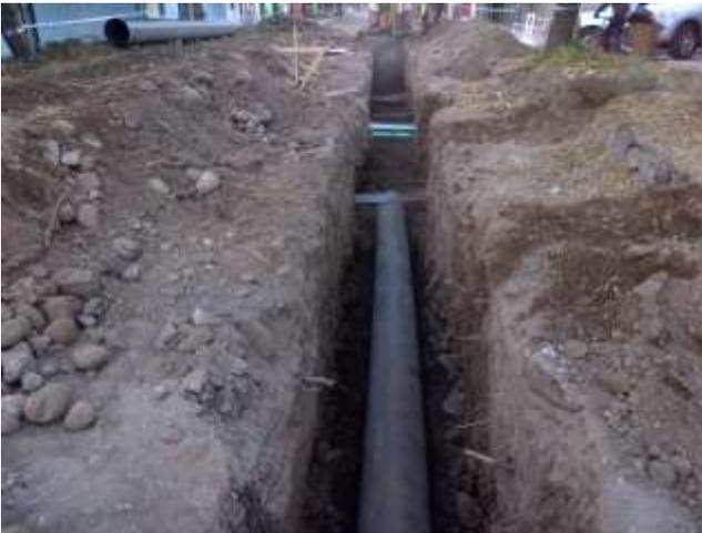
Instalación de tubería de HDPE para colector de aguas lluvias proyectado.
