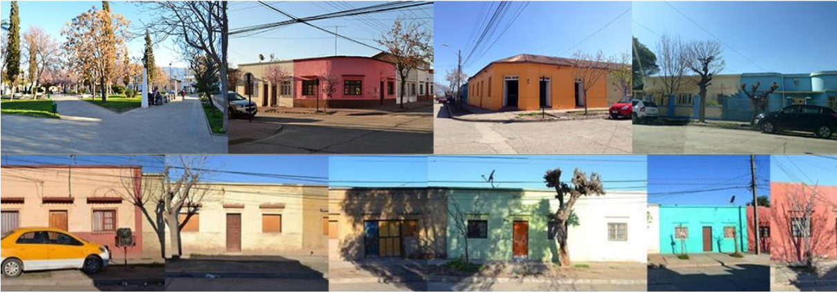
Figura 21_ Entorno Plaza Bicentenario y conjunto de viviendas en calle Brasil
